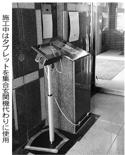
ネスぺが開発した並行運転システムの操作手順は従来の集合玄関機と同じ。タブレットのテンキーで部屋番号を押すと住民のインターホン代わりにのスマホに接続が行き、住民は映像を確認し通話、開錠ボタンを押すとオートロックが開錠されるシステムだ。料金は月額1台7万円(税抜)と実に安価のレンタル制になっている。使用にあたっては住民は専用アプリをインストールするだけ。ただし、同システムが火報設備などの連携機能を有していない点は注意が必要だ。
